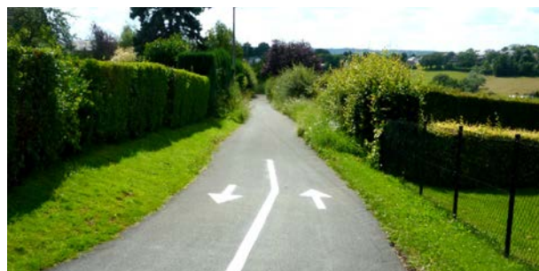
Voie des Steppes : nouveau revêtement
