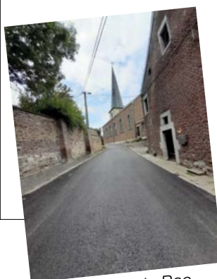
Phase 1 : rue du Bac
