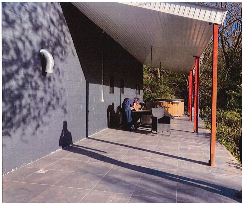
PHOTO 13 (objet de la demande : annexe arrière avec nouveau auvent et terrasse) : vue terrasse latérale droite
