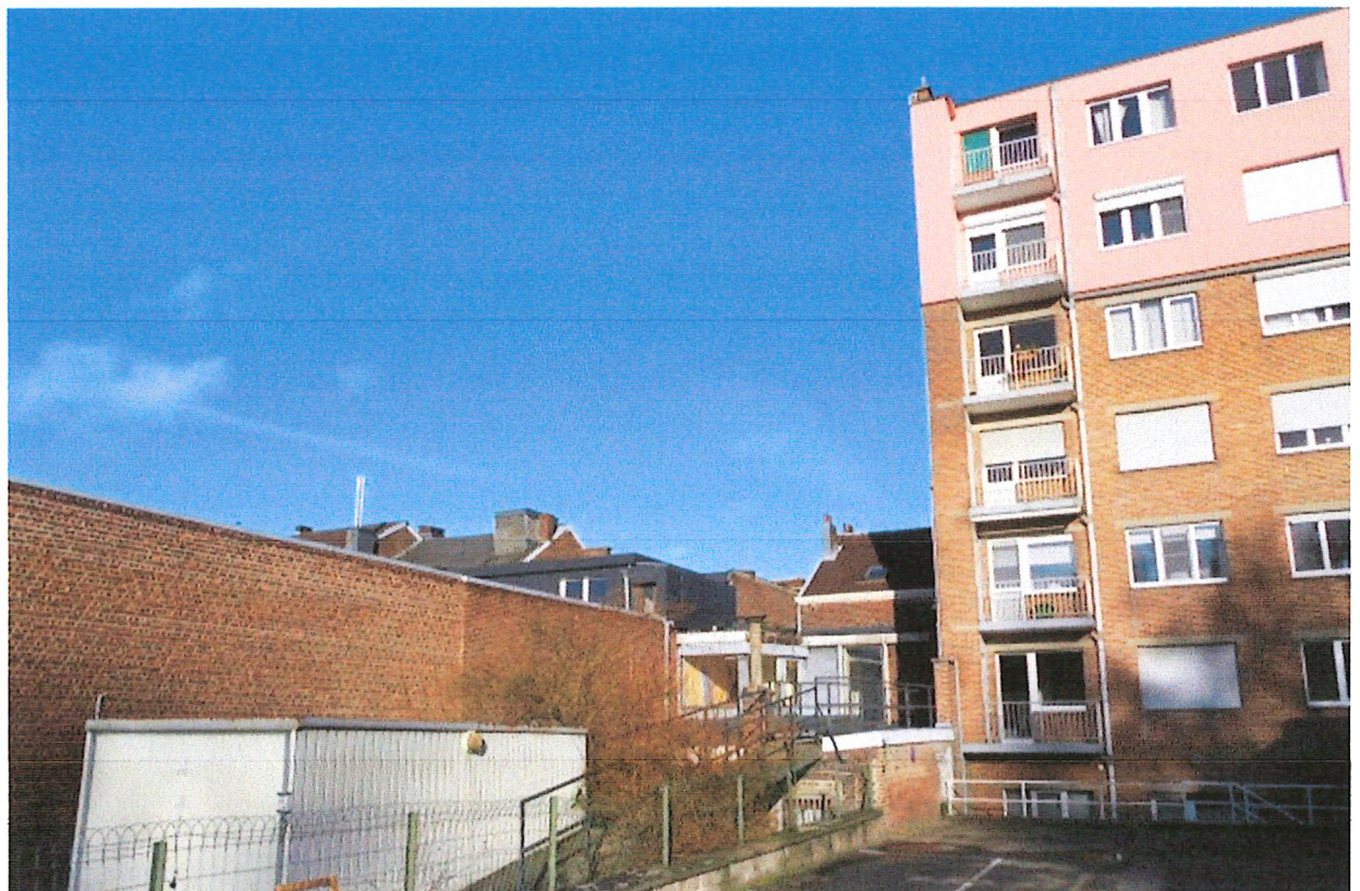
Photo 4 – Vue générale façade l'arrière
