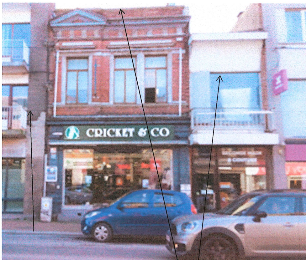
Photo 1 – façade à rue
