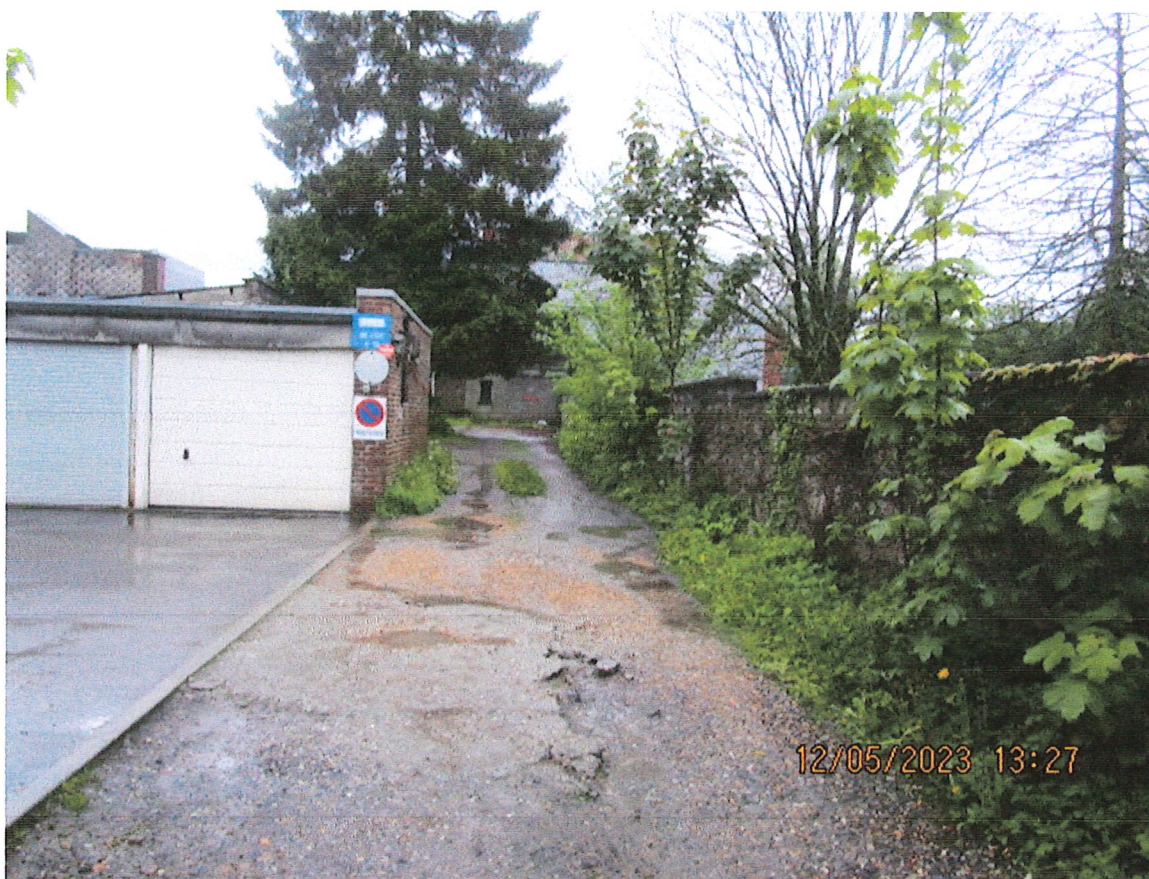
Photo 7 – Vue générale de l’impasse vers arrière n°206
