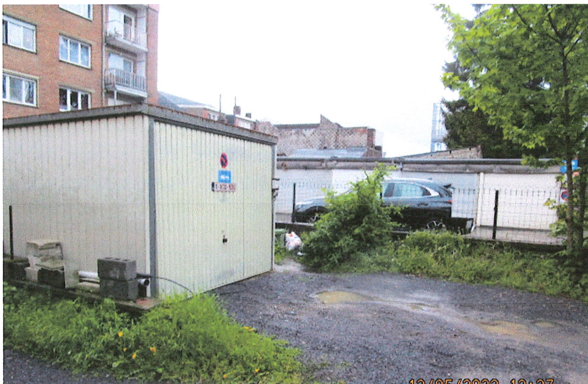
Photo 9 – Vue vers garages n° 206 avec garage n° 204
