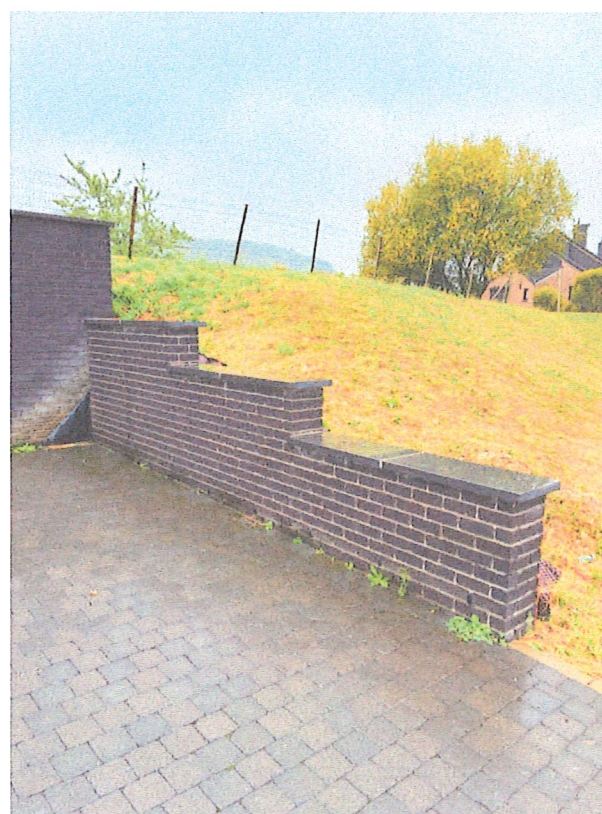
Photo 4 – Vue du mur à régulariser depuis la zone de parcage
