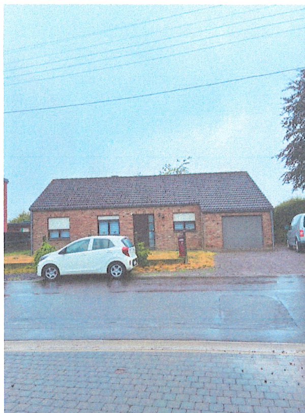
Photo 6 – Vue générale de la parcelle en vis-à-vis depuis l'allée
