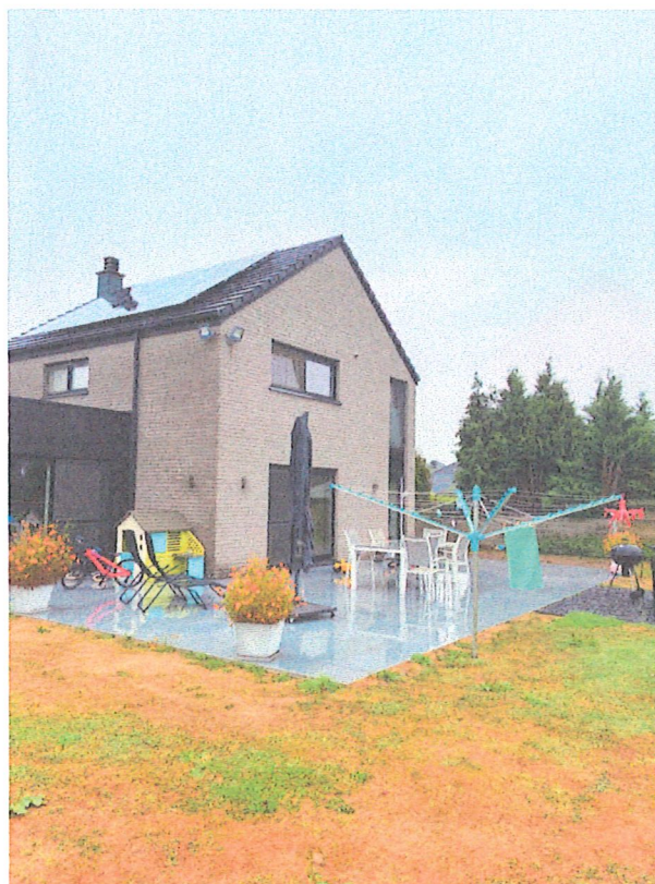
Photo 10 – Vue de l'implantation de l'extension depuis le sud-est
